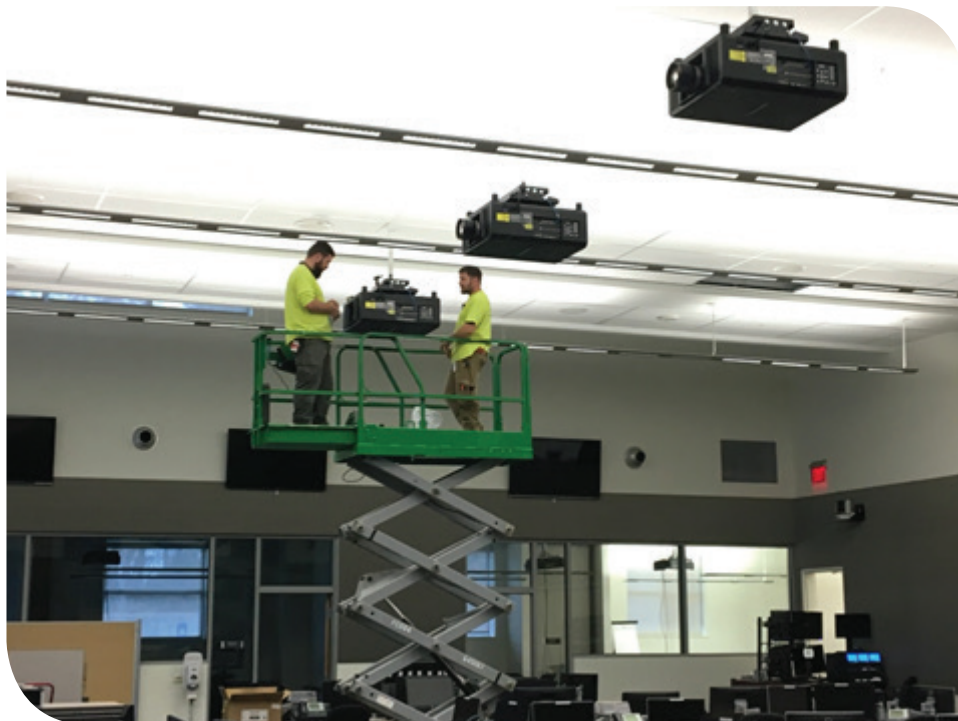
EOC AV update equipment install
